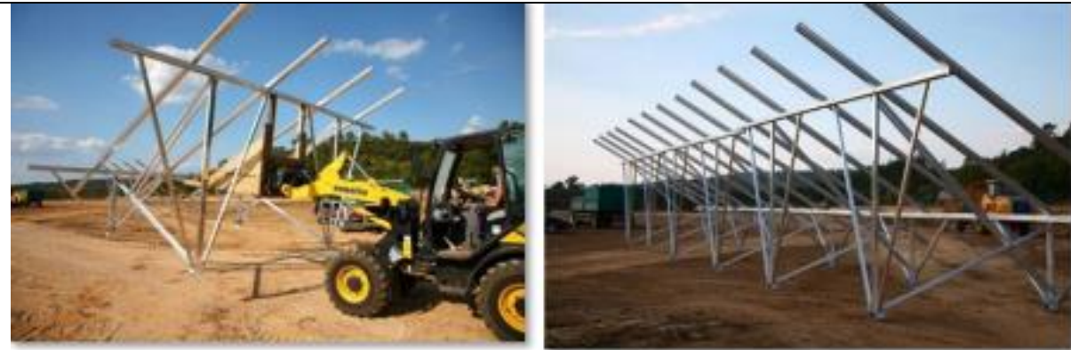
Photographie 5 : Exemple de structure porteuse métallique (Source : ENCI5 Environnement)
